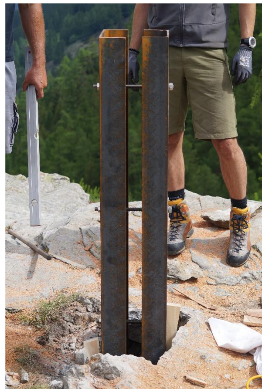
9 Montage Stahlsockel
